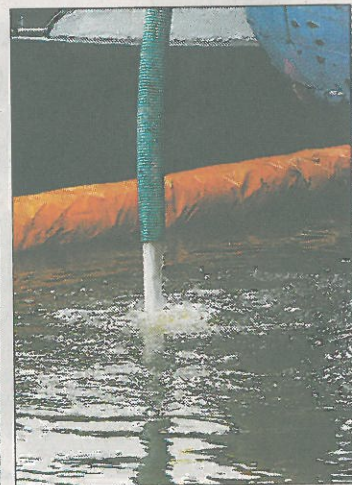
Mehrere Pumpen beförderten das Wasser nach draußen.
