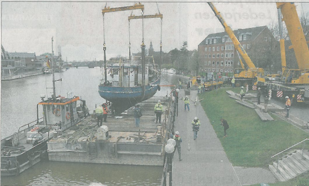
Spektakel im Leeraner Hafen: Mit Hilfe von zwei Autokränen wurde der Pannenkutter »Sirius« gestern auf einen Ponton gehoben.
