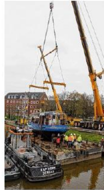
Ein zweiter Kran stabilisierte das Schiff.
